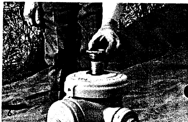
Remove hold down nut (Part #5).
